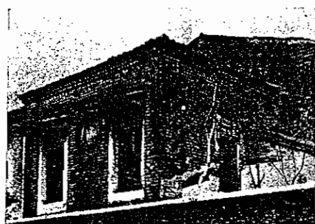
47. - Chiesa di Fallavecchia: corpo posteriore.
