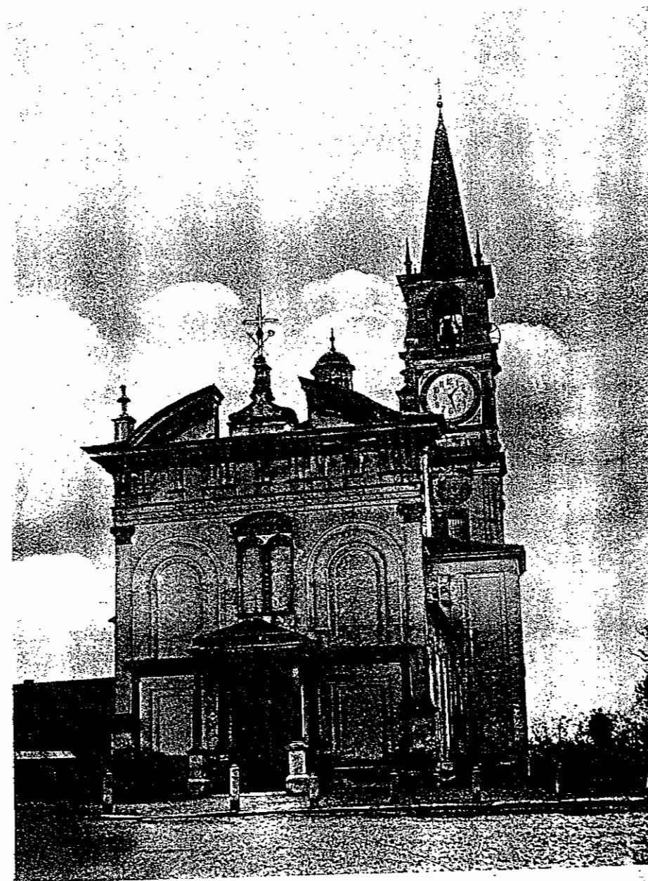
1. - Facciata della Chiesa di Bertonico.
