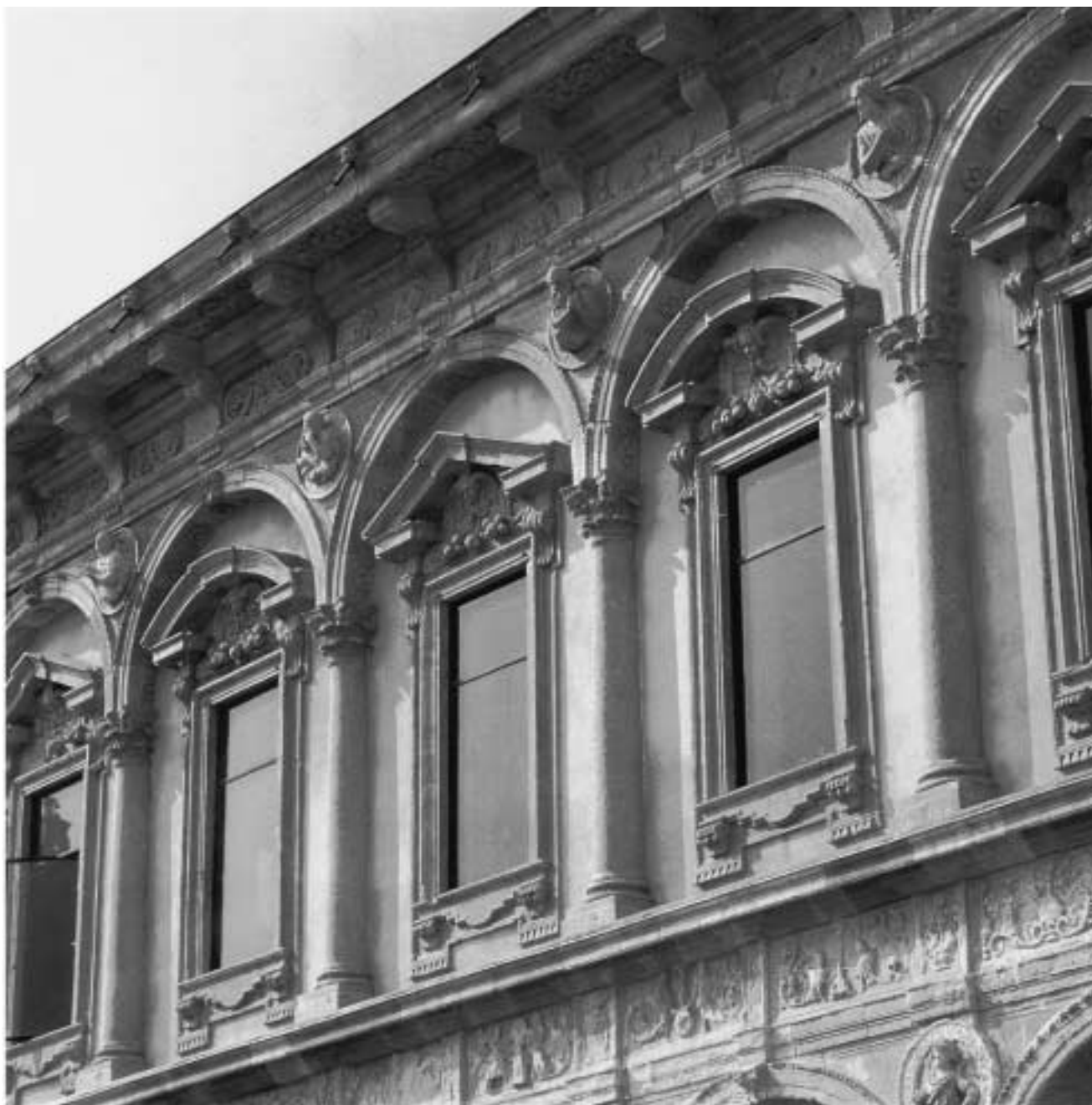
Cortile del Richini nella Ca' Granda, ora sede dell'Università: finestre inscritte nelle arcate chiuse dell'ordine superiore (da: "La Ca' Granda di Milano" "L'intervento conservativo sul cortile richiniano" – Progetto Monumenti Snam, 1993).
