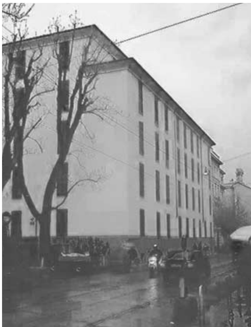
L'edificio di via Lamarmora, sede del nuovo poliambulatorio
