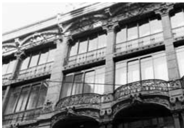
Figura 7 : Via Tommaso Grossi n°8 Archi e parapetti bombati, vetrate in cornici ad angolo smusso Le fotografie sono di Anna Maria Carloni
