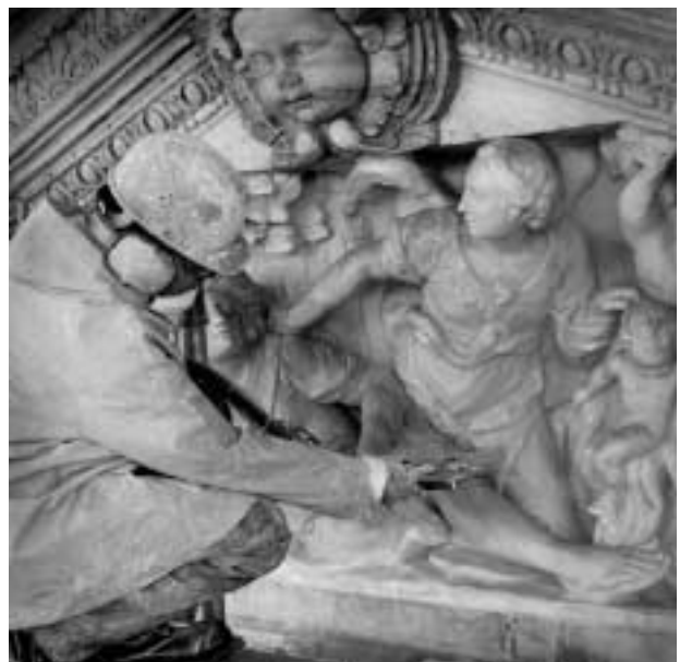
Altorelievo di facciata "Agar nel deserto" (meta' sec.XVII). Rimozione con getto d'acqua nebulizzata delle incrostazioni formatesi sul marmo e originarie dalla inquinazione atmosferica.
