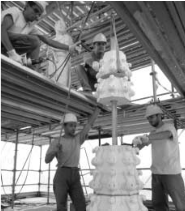
Cuspide di una guglia di facciata: collocazione dei nuovi elementi marmorei in sostituzione di quelli originali irrimediabilmente degradati. (Copyright fotografie: Veneranda Fabbrica del Duomo ed Enitecnologie Spa)
