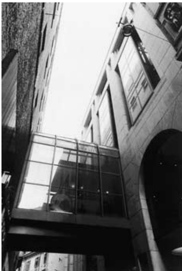
Figura 1: veranda che unisce i due edifici della Rinascente
