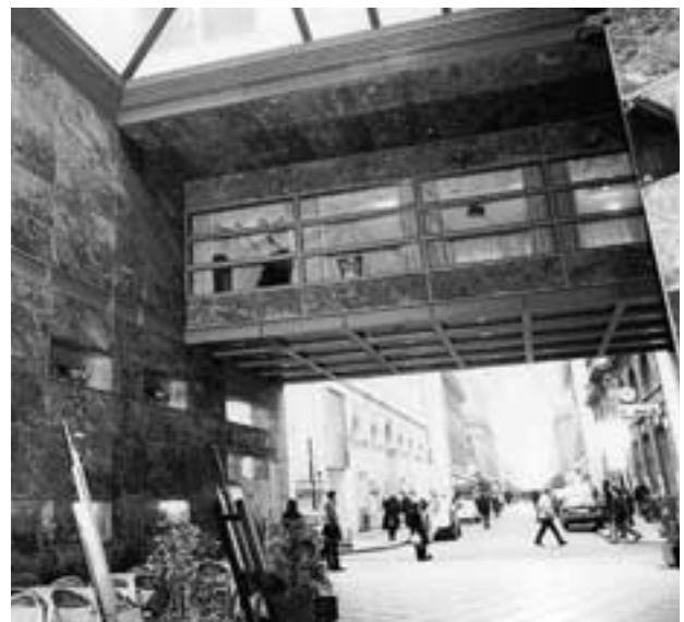
Figura 3: via Ciro Fontana . “Il passaggio ha un lucernario dal quale piove luce naturale...”.
