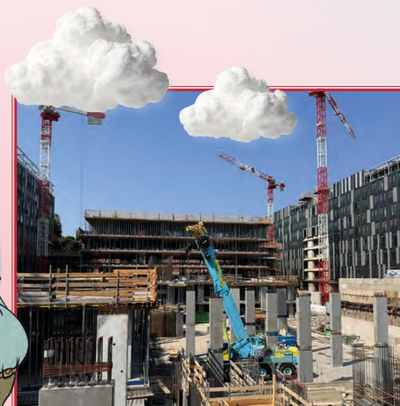
Il cantiere del Nuovo Policlinico - Settembre 2024
