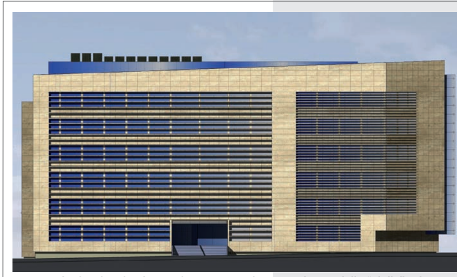
La facciata in pietra orientata a nord, caratterizzata dalle "ciglia" orizzontali
